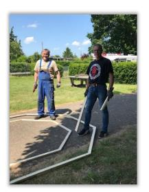
Für das Ausrichten der aus Beton bestehenden Bankelemente wurde zunächst ein Gerüst angefertigt.
